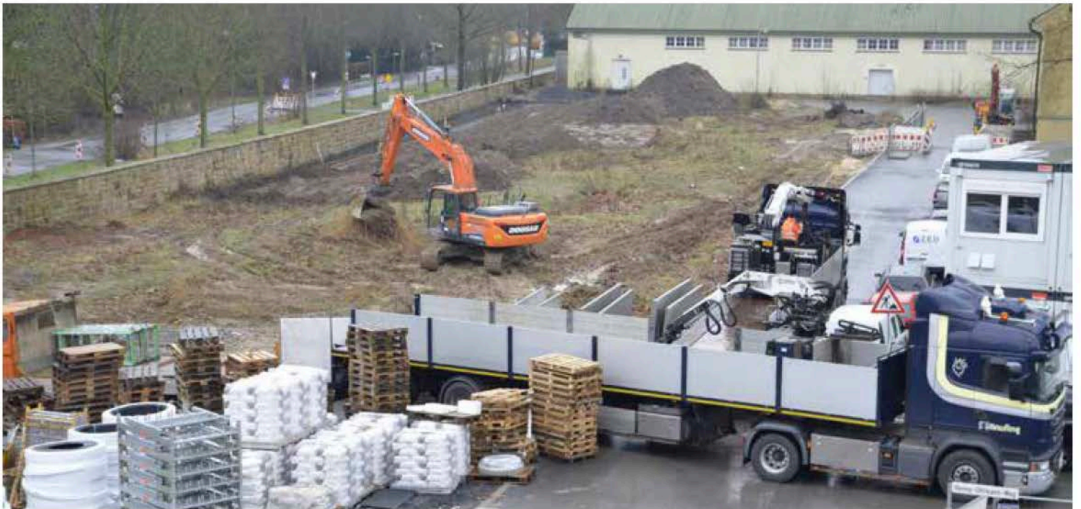
FOTO / Baubeginn für das Wohnprojekt KLiQ parallel der Mauer zur Gievenbecker Reihe. (Foto: Ludgerus Leuring)
