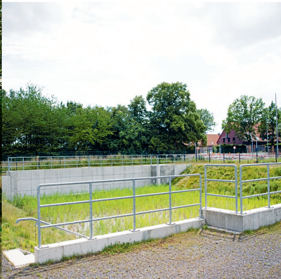
Stärker belastetes Regenwasser wird zunächst über einen Retentionsbodenfilter gereinigt, bevor es in den Gievenbach weitergeleitet wird.
